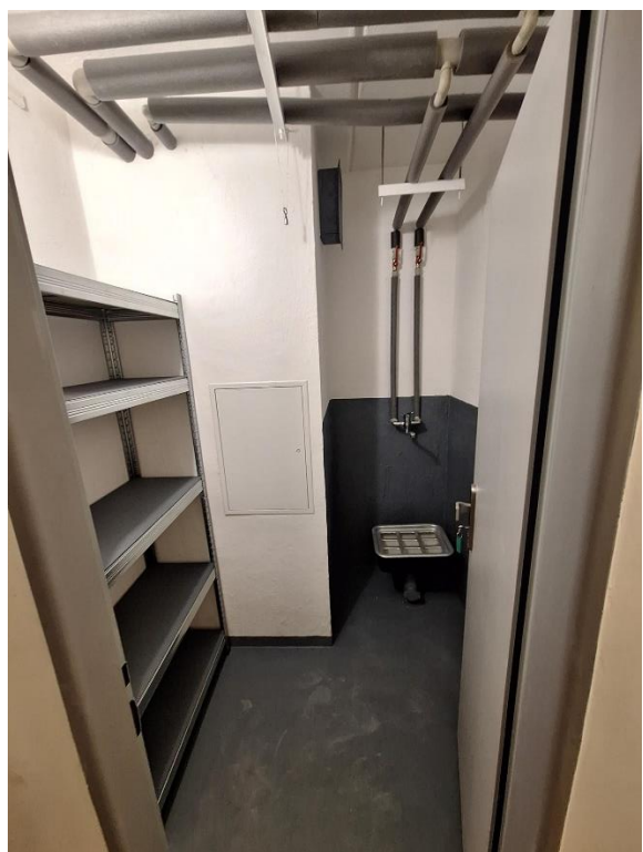
NOVÝ STAV – PO REKONSTRUKCI
